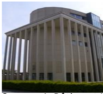
Campus 1, Bâtiment L
